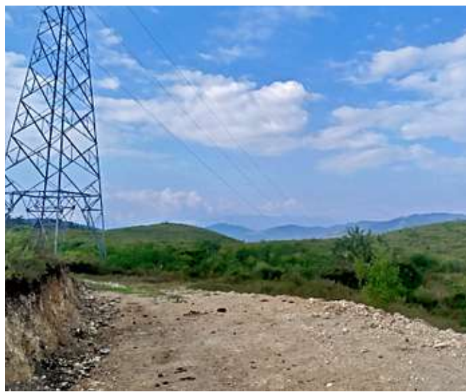
■ La brecha que fue abierta a finales de octubre para que Raquel Sosa entrara al predio "La Lagunita".
